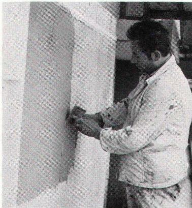
– in jeder gewünschten Struktur. Die geschlossene Außenhaut ist Wärmedämmung, Putz und Anstrich zugleich.
