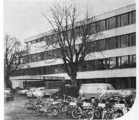
Freie Evangelische Schule Basel, Bauzeit 1973/74 Schulgebäude mit 28 Klassenzimmern, Turnhalle und Mensa. Garantierte Preise und Termine (Unterschreitung des Zeitplans um ein volles Schulquartal). Architekten: G. Bellussi und R. Tschudin, Architekten SIA, Basel.
