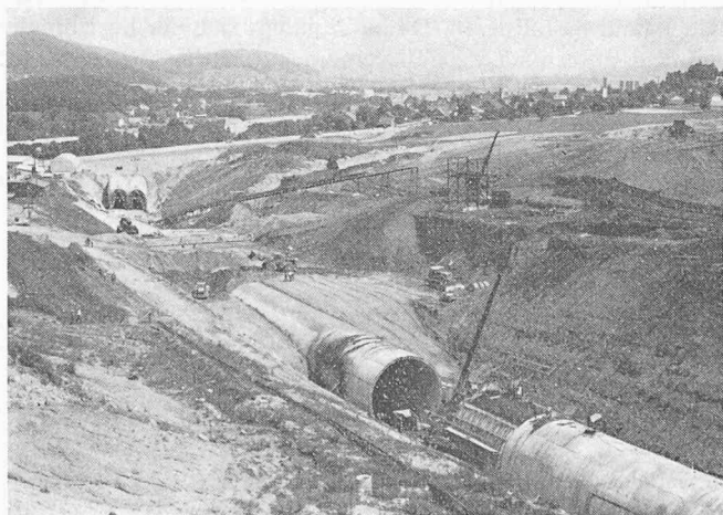
Bild 4. Das Tunnelgewölbe im Bau. Im Vordergrund rechts wird gerade ein Gewölbeelement betoniert, während in Bildmitte die Schüttarbeiten im Gange sind.
