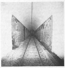
Bild 9. Abdichtung von Mauerwerk mit einer Gunitverkleidung im Tunnel Gaggetto di dentro. Vorn ganzes Profil, hinten nur Kalottenbereich verkleidet; mit Weisskalk und Weisszement gespritzt
