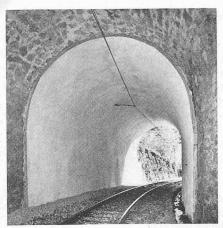
Bild 8. Durch Vollverkleidung mit Gunit abgedichtete Portalstrecke des Tunnels Gaggetto di dentro
