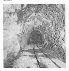
Bild 4. Ausgemauerte Strecke des Tunnels Riale Verdasio mit Gleisvernässungen
