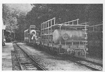
Bild 5. Bauzug im Bahnhof Ponte Brolla. Vorn Gerüstwagen mit Bauwasser-Drucktank, hinten Gunitwagen mit Trockengemisch-Aufbereitungsanlage
