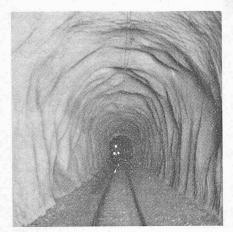
Bild 7. Mit Spritzbeton konsolidierte Felsstrecke des Tunnels Dirinei
