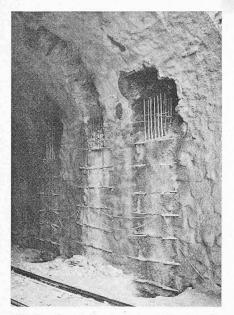
Bild 13. Bau des senkrechten Teils eines Gewölbebogens aus armiertem Spritzbeton im Tunnel Ruinacci
