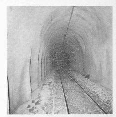
Bild 11. Zurückversetzte Widerlagerpartie im Tunnel Frana di Corcapolo
