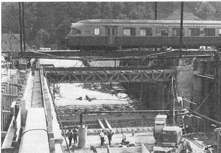
Bild 8. Auflagerwände mit Holzspriessung und den grossen Hilfsbrücken der SBB. Die Bodenplatte der Unterführung ist bereits betoniert. Im Vordergrund ist der Sammelkanal erkennbar
