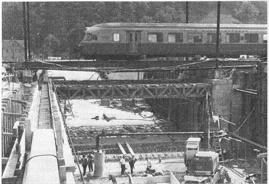
Bild 8. Auflagerwände mit Holzspriessung und den grossen Hilfsbrücken der SBB. Die Bodenplatte der Unterführung ist bereits betoniert. Im Vordergrund ist der Sammelkanal erkennbar
