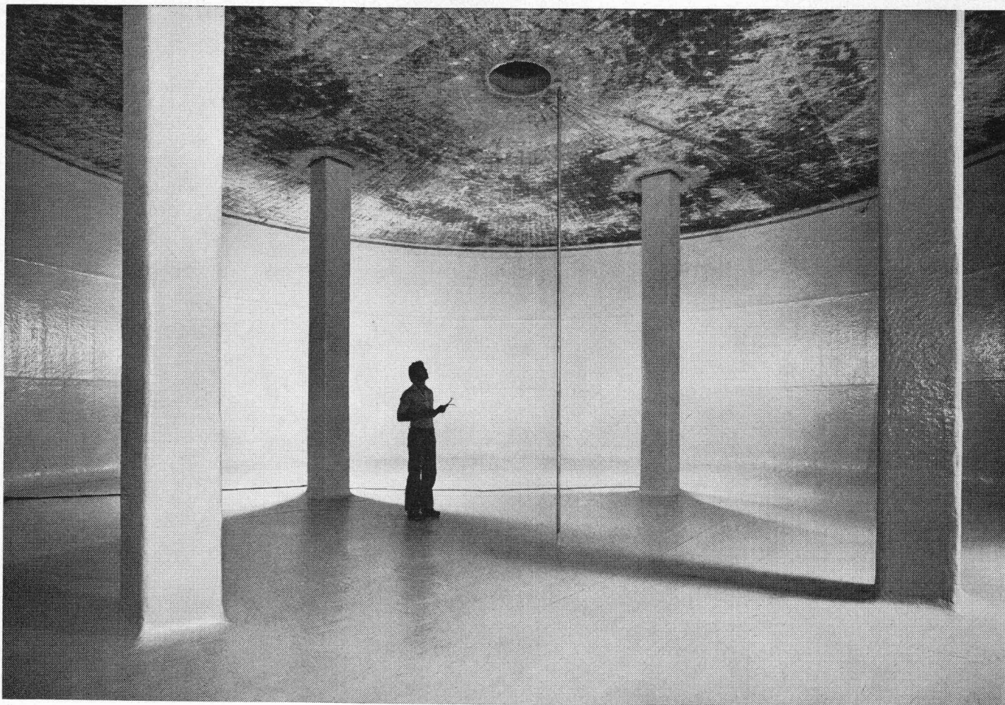
Gemeinnützige Baugenossenschaft Limmattal, Zürich 2 Tanks, total 1 000 000 Liter Heizöl
