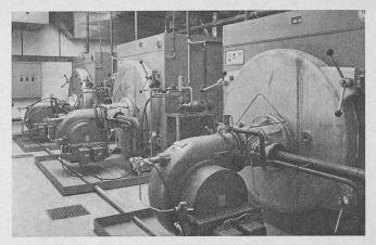
Hochleistungskessel mit Gas/Öl-Zweistoffbrennern
