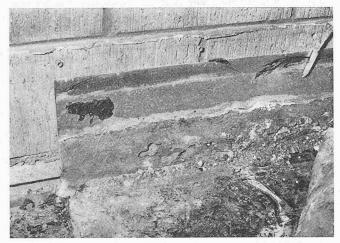
Sondierstelle, Zementüberzug und Zementschrittplatten entfernt; starke Korrosion bis zur Perforation beim vertikalen Teil des Winkelbleches
