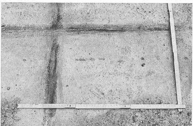
Dachhautoberseite, Schutzschicht Sand und Kies entfernt. Geradlinig verlaufende Wülste und Risse in der Dachhaut über den Fugen der Wärmedämmplatten
