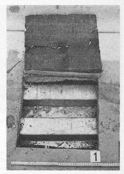
Sondierstelle, ganzer Dachbelag bis auf die Tragkonstruktion durchgeschnitten und aufgeklappt; Dampfsperre gerissen und mit dem Profilblech nicht verklebt
