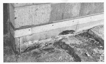
Winkelblechanschluss an das Gebäude, Zementschrittplatten und Zementüberzug teilweise entfernt; Zementüberzug in direktem Kontakt mit dem Winkelblech, dieses ist auf der Vorderseite nicht geschiitzt
