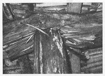
Bild 8. Druckerscheinungen im Sondierstollen im Nordabschnitt des «Mesozoikums»
