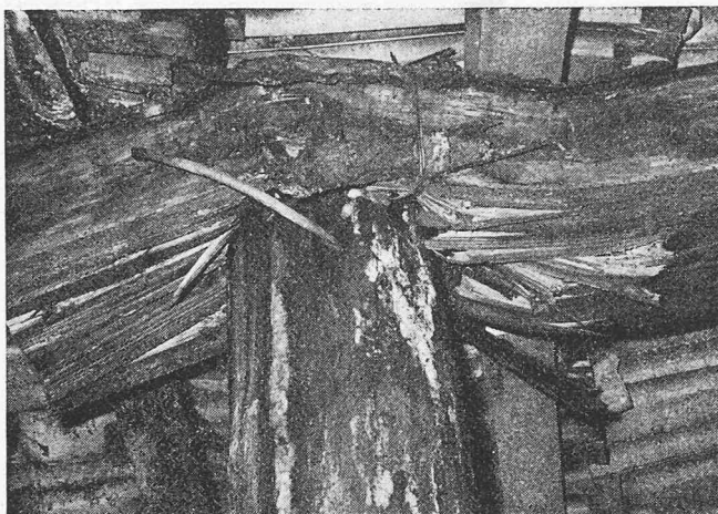
Bild 8. Druckerscheinungen im Sondierstollen im Nordabschnitt des «Mesozoikums»
