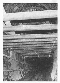
Bild 5. Zweiteiliger Paramentstollen des Haupttunnels
