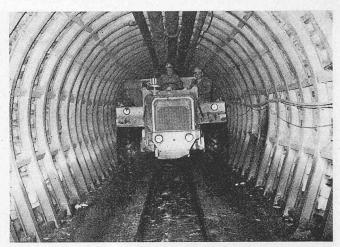
Bild 9. Umfahrung des «Mesozoikums» durch den erweiterten Sicherheitsstollen
