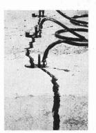
In einer Fabrikationshalle mit einer ganzen Anzahl vollautomatischer Drehbänke muss das Fundament eines Drehbankes entfernt werden – erschütterungs- und vibrationsfrei, geräuschlos und ohne einen Arbeitsunterbruch an den andern Drehbänken zu verursachen.
