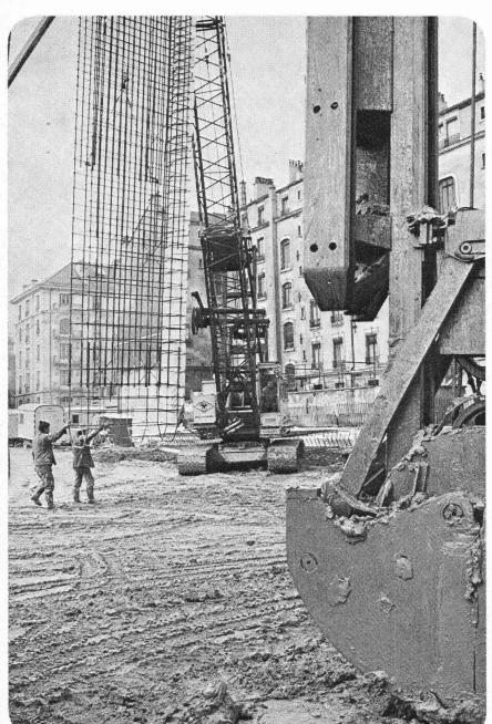
angewendet bei Hoch- und Tiefbauarbeiten, erlauben Baugrubenabschlüsse in den verschiedensten Formen und dienen auch als Stütz- und Dichtungswände.
