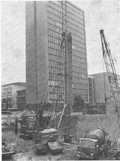
Links: Bild 4. Links: Geführter 5-t-Greifer im Einsatz. Der Greifer mit dem Führungsgestänge ist an einem Landsverk-Raupenchassis montiert. Rechts: Betonieren eines Wandelementes mit Fertigbeton
