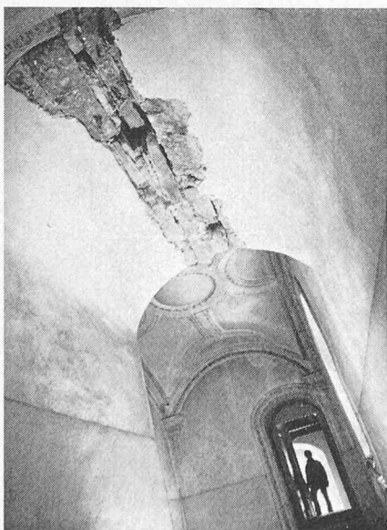
Bild 6. Gewölberisse über den Seitengalerien mit Durchblick zur Turmtreppe (vgl. Querschnitt Bild 4)
