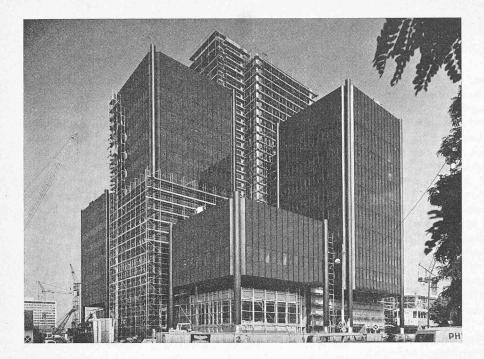
Als Feuerschutz wurde Pyrok-Spritzputz verwendet. Erstmals in der Bundesrepublik Deutschland ist es hierbei gelungen, den Feuerschutz schon vorher im Werk auf grössere Stahlkonstruktionsteile - Randträger und Stützen - zu spritzen. Bisher wurde die Stahlkonstruktion erst nach der Montage auf der Baustelle mit Feuerschutz versehen.
