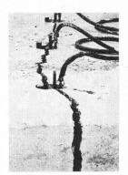
In einer Fabrikationshalle mit einer ganzen Anzahl vollautomatischer Drehbänke muss das Fundament eines Drehbankes entfernt werden — erschütterungs- und vibrationsfrei, geräuschlos und ohne einen Arbeitsunterbruch an den andern Drehbänken zu verursachen.
