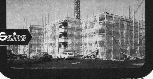
Howagaine-Folien sind durchsichtig, isolierend und säurebeständig. Sie eignen sich auch vorzüglich für provisorische Schutzdächer bei Umbauten, für Fensterabschlüsse bei Rohbauten, zur Abschirmung von wertvollem Baumaterial, als Abdeckmaterial bei Strassenbauten, für Trennwände und Schallisolationen beim Betonieren, für Barackenbauten usw.
