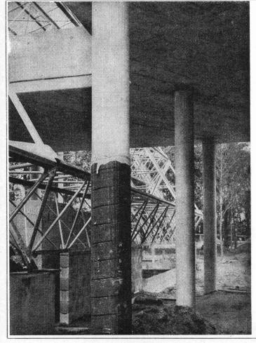
Aussparungsrohre für Hohlkörperdecken
