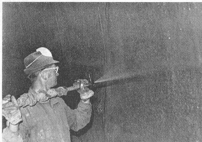
Bild 3. Beschichtungsvorgang mit Kunststoffmörtel auf Ulm
