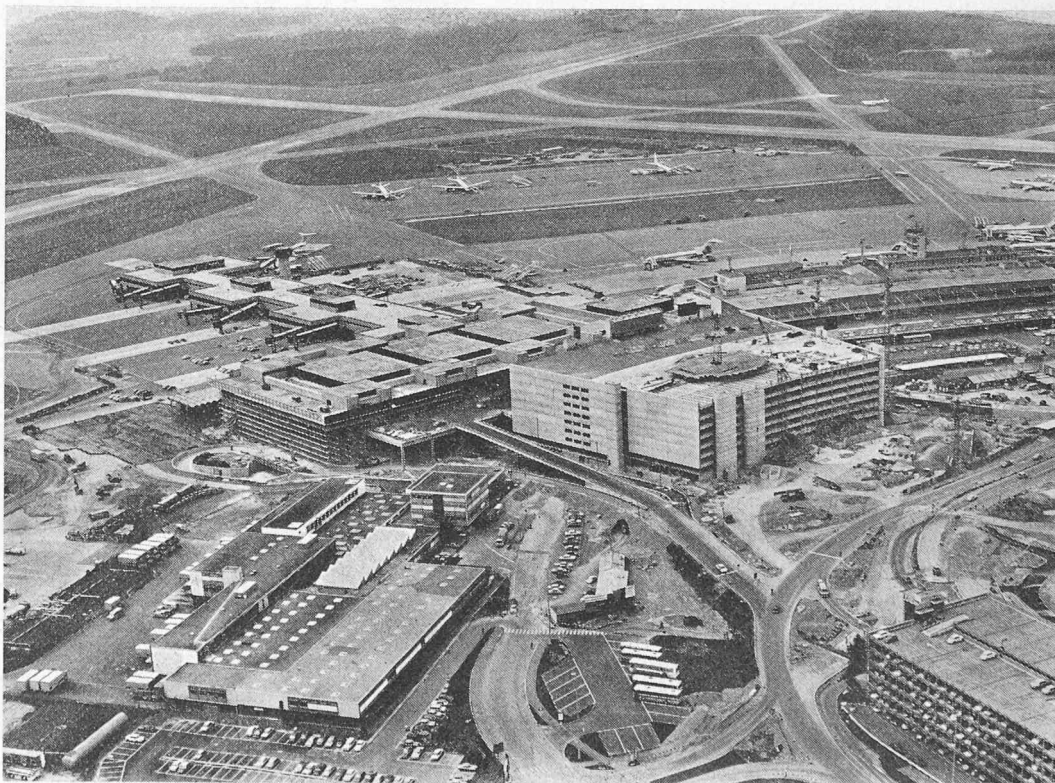
Bild 1. Gesamtansicht des Terminals B (Bild Mitte). Von rechts nach links: Parkhaus B, Abfertigungsgebäude und Fingerdock. Rechts aussen der Terminal A; im Vordergrund (links unten) das Borddienstgebäude
