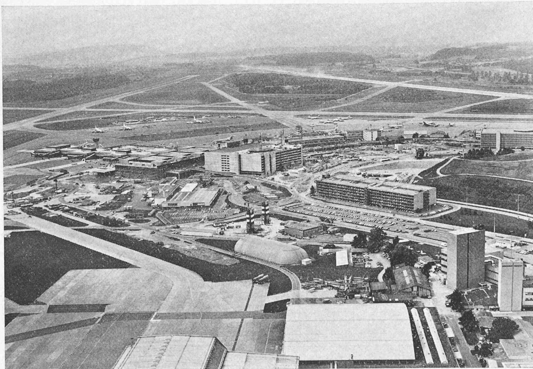
Bild 3. Flughafenareal von Süden aus. Die drei Parkhäuser beherrschen das Bild: Rechts vom Terminal B das Parkhaus B, rechts aussen das Parkhaus F mit der Fussgängerüberführung zum Terminal A. In der Bildmitte das Parkhaus E
