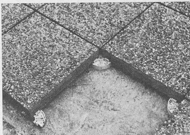
Montage von Bodenplatten auf Kunststoffelementen
