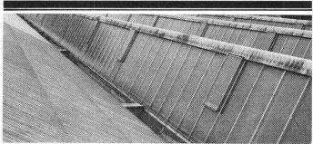
Kittlose Industrieverglasung von Tuchschmid als Shed- oder Satteloberlicht, Fassadenlichtband oder Vordach.
