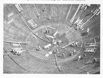
Bild 12 (rechts). Reaktorgebäude. Armierung der inneren Kalotte
