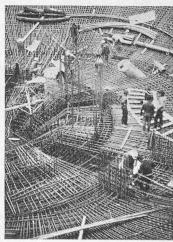
rung der Kalotte noch eingebaut werden kann, mussten auf der Baustelle Versuche im Massstab 1:1 durchgeführt werden, bevor die endgültigen Pläne und Eisenlisten erstellt werden konnten. Einen Eindruck von der Bewehrung der inneren Kalotte zeigt das Bild 12.
