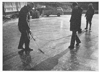
Bild 5. Überprüfung der Isolierung mit dem Hochspannungsprüfverfahren
