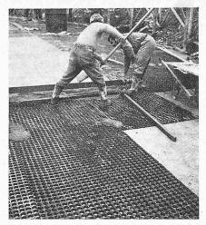
Bild 4. Einbau der Drainageschicht beim Reaktorgebäude
