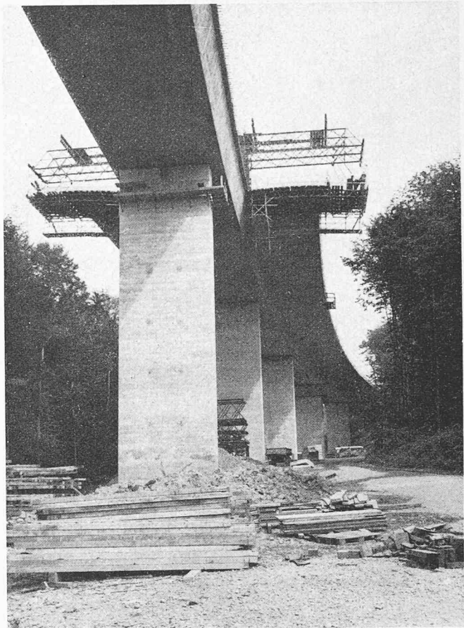
Bild 5. Bau der Randabschnitte auf einem Lehrgerüst
