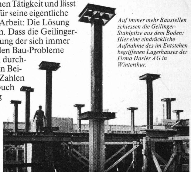
Auf immer mehr Baustellen schießen die Geilinger-Stahlpilze aus dem Boden: Hier eine eindrückliche Aufnahme des im Entstehen begriffenen Lagerhauses der Firma Hasler AG in Winterthur.
