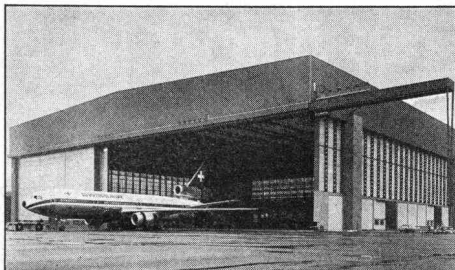
Flugzeughalle von 16 000 m 2 Überdeckung mit Rolltoren von 26 m Höhe
