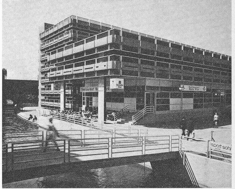
Das Parkhaus von Osten, im Vordergrund der Annexbau mit Restaurant und Läden
