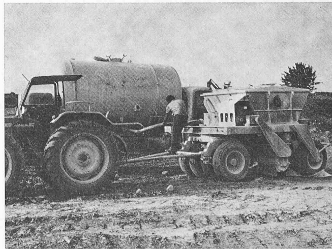
Bild 2. Der Silolastwagen beschickt einen AMMANN-Zement- und Kalkstreuer ZK3 auf der Einbaustelle
