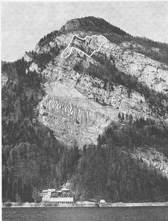
Bild 1. Schwarzberg von Süden. In Bildmitte der Steinbruch Köppl im Kieselkalk, darüber die Felswände des Schrattenkalkes mit Umgrenzung der am 21. Januar 1974 abgestürzten Felspartie. Zustand Sommer 1973 (Photo Jürg H. Meyer)
