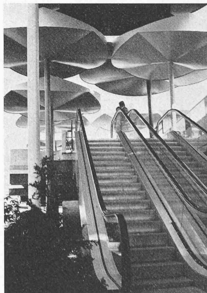
Detailansicht der Konstruktion, Spannweite der Hauptträger: 26 m
