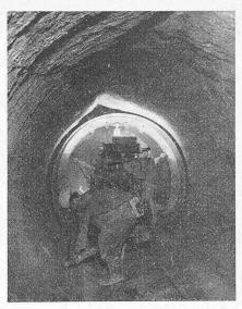
Bild 8. Aufweiten der eingerollten Bleche mit dem Spannwagen und präzises Versetzen zum anschliessenden Anschweissen an die Bleche der Sohltübbinge
