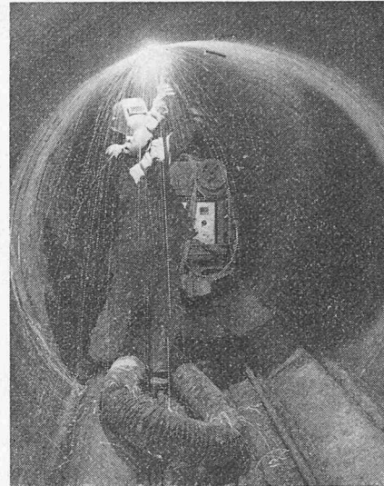
Bild 9. Verschweissen der 4 mm starken Bleche
