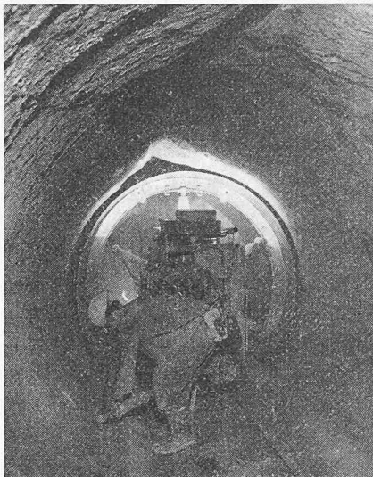
Bild 8. Aufweiten der eingerollten Bleche mit dem Spannwagen und präzises Versetzen zum anschliessenden Anschweissen an die Bleche der Sohlübbinge
