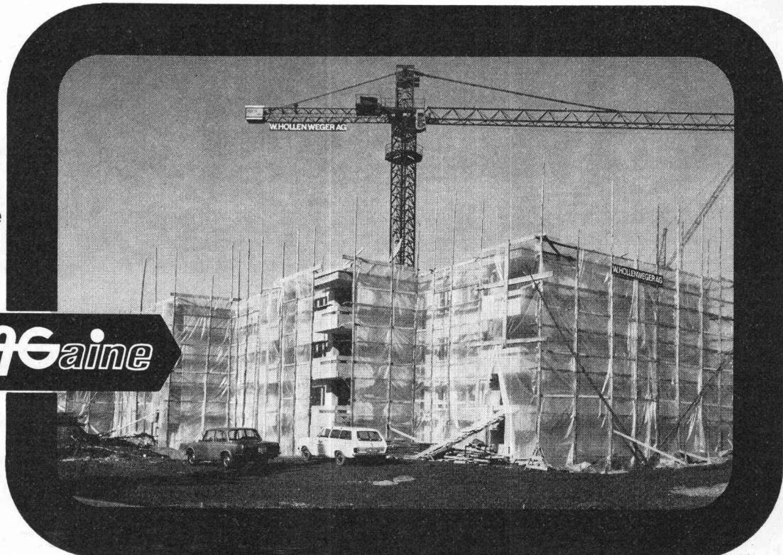
Howagaine-Folien sind durchsichtig, isolierend und säurebeständig. Sie eignen sich auch vorzüglich für provisorische Schutzdächer bei Umbauten, für Fensterabschlüsse bei Rohbauten, zur Abschirmung von wertvollem Baumaterial, als Abdeckmaterial bei Straßenbauten, für Trennwände und Schallsolationsen beim Betonieren, für Barackenbauten usw.
