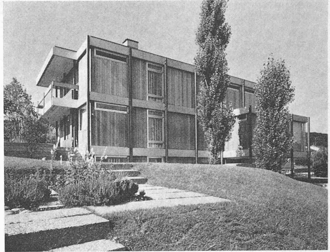
Westfassade mit holzverschalteten Aussenwandelementen
