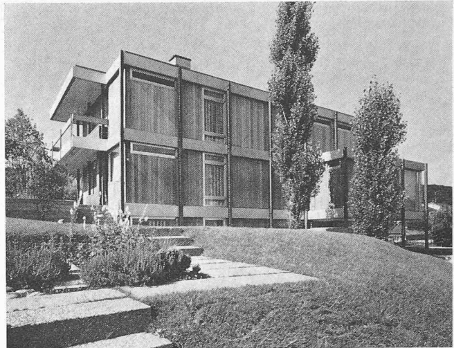
Westfassade mit holzverschalteten Aussenwandelementen
