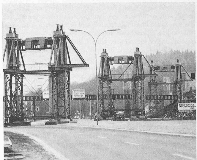
Bild 7. Die Montagehilfskonstruktion vor dem Einschieben
