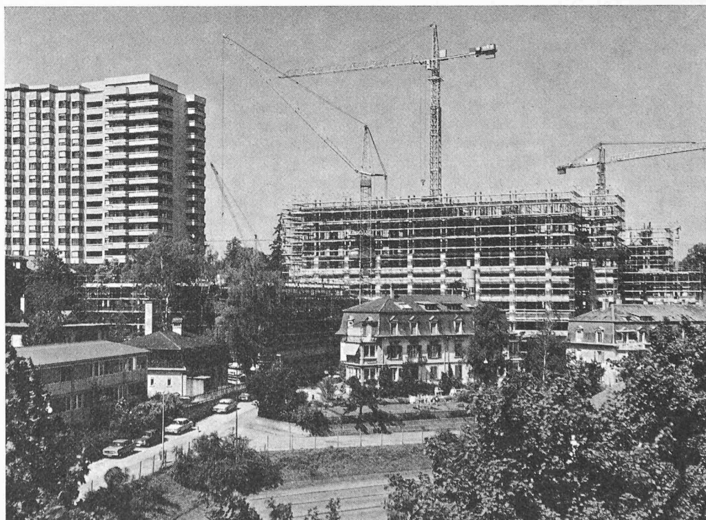
Bild 2. Ansicht von Südwesten, aufgenommen am 22. Juli 1974. Links hinten das Bettenhochhaus des Inselspitals, davor die Aula (Teil I). Daneben der Teil II mit den schlanken Zwillingstützen. Rechts sind die Deckenauskragungen sichtbar. Bis zum 2. Geschoss sind die Horizontal- und Vertikalelemente der Fassade versetzt. Darunter ist das niedrige technische Zwischengeschoss im G1 zu erkennen
