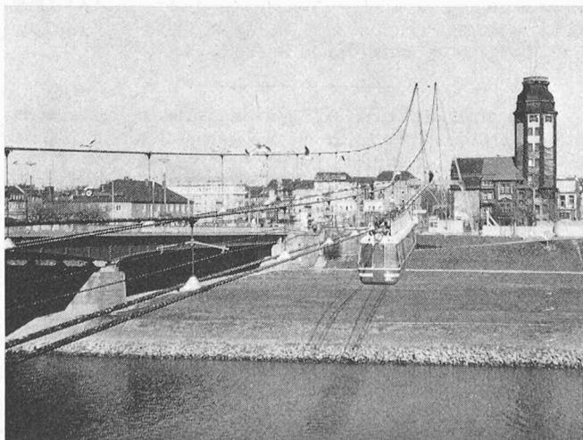
rung längs einer leicht gekrümmten Strasse, wobei die erforderlichen horizontalen Seilablenkungen an besonderen Stützen des in Bild 2 gezeigten Typs erfolgen.
