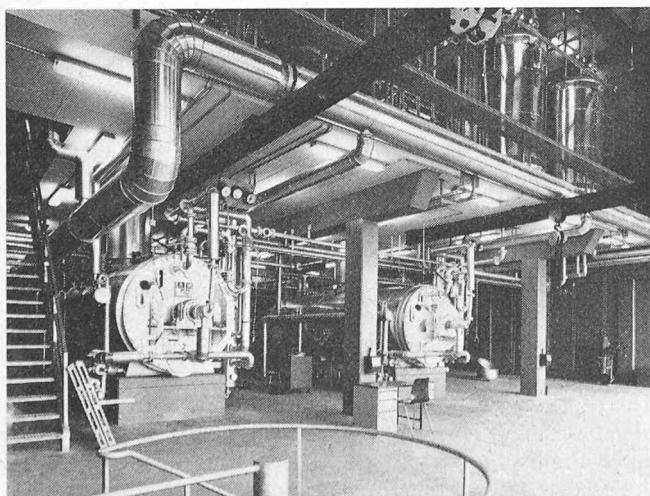
ausgeschlossen sind. In dem kompakten und völlig geschlossenen Bau der Fleischmehlfabrik herrscht in sämtlichen Fabrikations- und Lagerräumen ständig ein geringer Unterdruck. Die Abfälle werden mit dem Lösungsmittel Perchlorylen behandelt und in einem völlig geschlossenen System geruchlos so verarbeitet, dass die Abluftmengen minimal bleiben.
