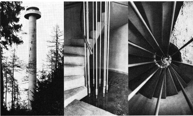
Vorgespannter Aussichtsturm in Lenzburg Ausführung durch Spannbeton AG Lyssach
