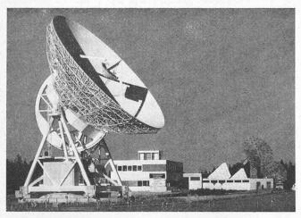
Auf ihrer Reise zur Sonnenumkreisung wird die Sonde Helios vom deutschen Satelliten-Kontrollzentrum in Oberpfaffenhofen aus überwacht und gesteuert. Über eine 30-m-Parabolantenne in Lichtenau bei Weilheim in Oberbayern werden die Funksignale an die Sonde im Weltraum gesendet. Diese Antenne ist Teil des deutschen Bodenbetriebssystems (Photo Krupp)
