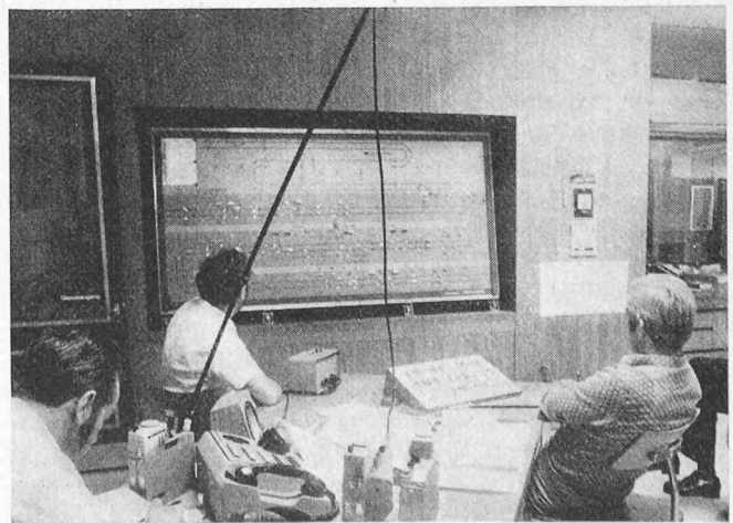
Bild 2. Die neue Kommandotafel des Integra-Domino-67-Spurplan-Stellwerks in der Station Wassen (Photo R. E. Hopfner, Buochs)
