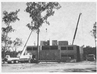
Bild 8. Aufstellen der Rahmentragwerke aus vorfabrizierten Betonelementen
