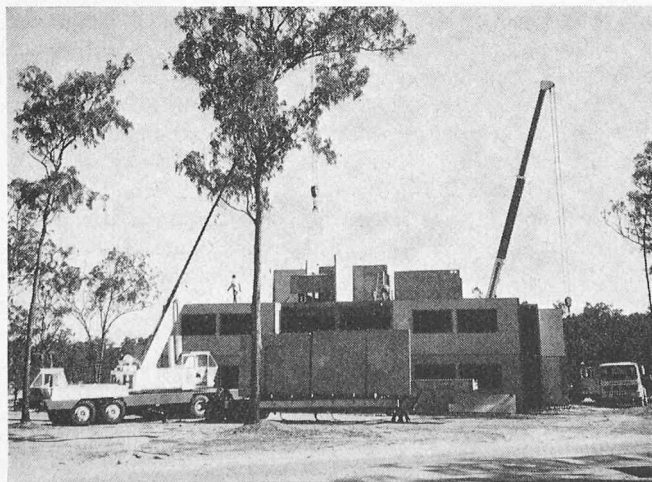
Bild 7. Bei allen Wohnhäusern wurden vorfabrizierte tragende Wände verwendet
