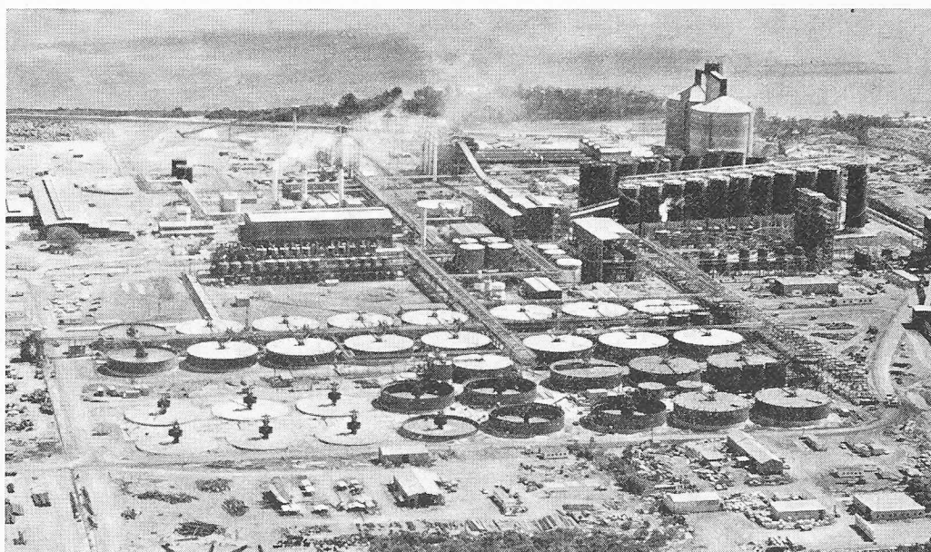
Bild 5. Ansicht des Tonerde-werkes von Osten. Zustand Sommer 1972
