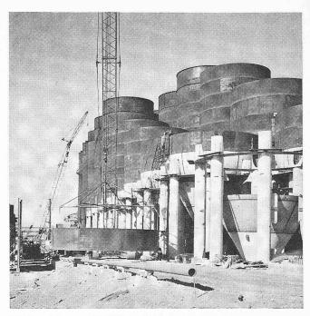
Bild 2. Montage der 3000-m3-Hochzersetzer
