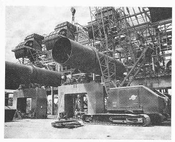
Bild 3. Montage der Drehöfen zur Kalzinierung der Tonerde
