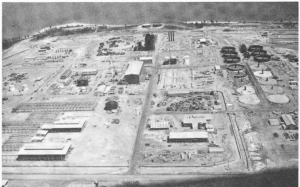
Bild 1. Fabrikansicht von Süden, Bauzustand Oktober 1970
