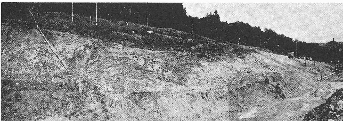
Bild 11b. Böschungsrutschung nach einer Woche
