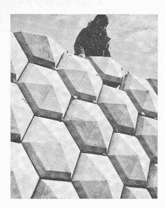
Bild 5, links. Verlorene Schalung aus vorgefertigten Glasfaserbetonteilen
