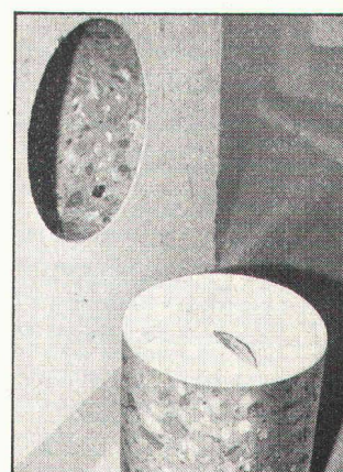
Millimetergenaues Bohrloch mit Bohrkern. Zuputzarbeit erübrigt sich.
