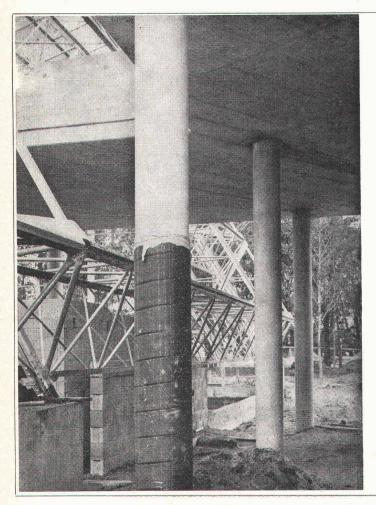
Aussparungsrohre für Hohlkörperdecken
