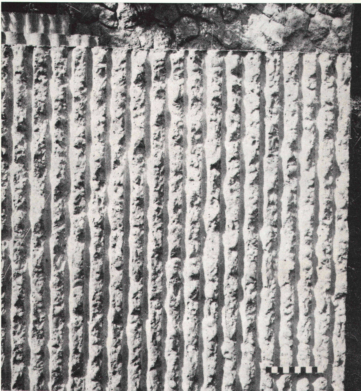
PREWI-Struktur «ALLEGRETTO-cassé», Polystyrol-Wegwerfeschalungsmatrize mit Trennfilm «X-X», für Ortbeton (2,75 × 0,80 × 0,03 m)
