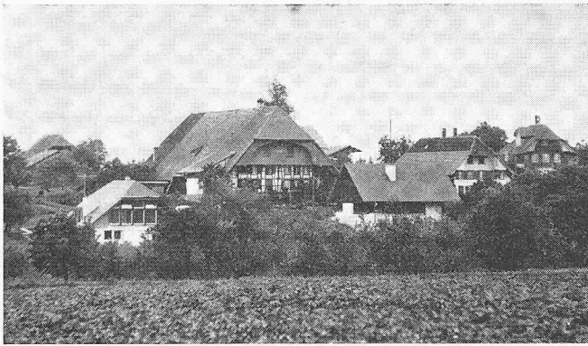
Buech bei Mühleberg BE. Optimale Eingliederung neuer Wohnbauten in ein bestehendes Ortsbild. (Photo: P. Aebi)
