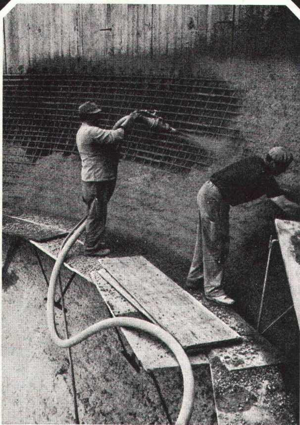
Kläranlage Frauenfeld: Spritzbetonarbeiten am Faulbehälter
