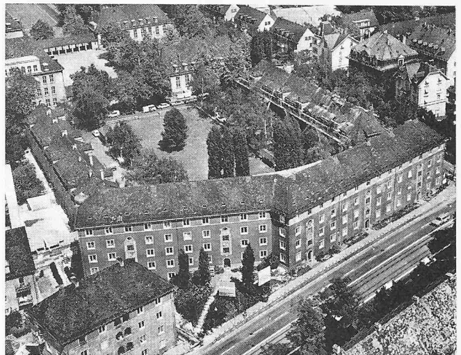
Die in Sanierung befindliche Wohnkolonie «Im Birkenhof» in Zürich Unterstrass (erbaut 1926, 101 Wohnungen)
