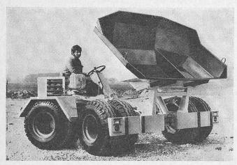
Beim Bau von Betongüter- und Forstwegen transportiert der neue schweizerische Dumper mit 2,2 t Tragkraft und einem Bodendruck von nur 0,9 kg/cm² den Frischbeton zum Fertiger
