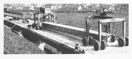
Bild 2: Bauwerk Urmiberg: Ein vorfabrizierter Träger wird durch zwei Spezialfahrzeuge («Elefanten») an den Verwendungsort geschoben. Im Hintergrund links das 84 m lange Versetzgerüst.
