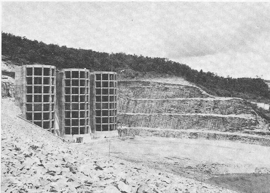
Bild 8. Einlaufbauwerke. Die Personen am Fusse des mittleren Bauwerkes geben einen Eindruck der Grösse; die Rechen sind noch nicht montiert. Im Vordergrund ist die Rip-Rap-Verkleidung des Dammes sichtbar und auf der rechten Bildhälfte die sauber geschos-sene Felsböschung des Einlaufkanales
