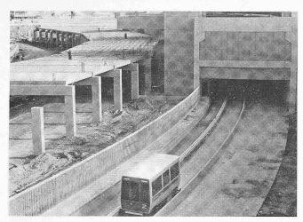
Bild 5. Einführung einer Airtrans-Linie mit U-förmigem Trog als Fahrweg in ein Terminalgebäude
