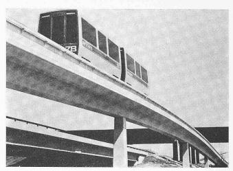
Bild 6. Hochliegender Airtrans-Fahrweg bei der Kreuzung anderer Verkehrswege – ausgeführt in Fertigteilbauweise mit farbigem Beton – Fahrt einer Doppeleinheit (80 Personen)
